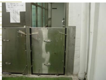
防水閘門(左圖：裝設前；右圖：裝設後)
