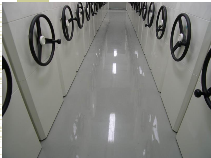
環氧樹脂(EPOXY)地坪
